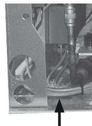
Passer les tubes avec précaution le long des faisceaux de câbles et des composants dans l'appareil...
